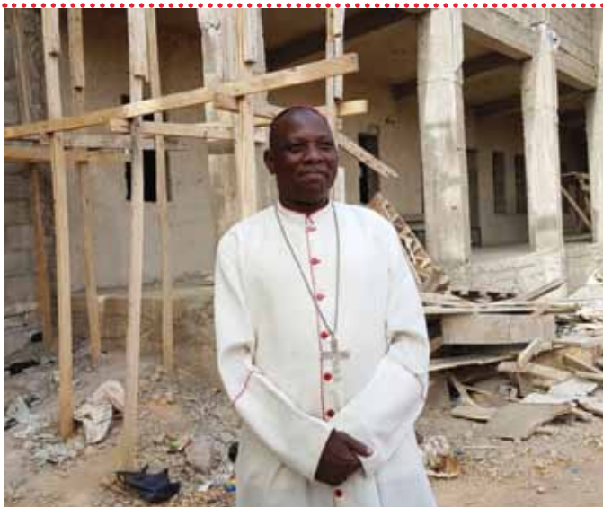
Bischof Oliver Dashe Doeme vor der Baustelle seiner Kathedrale, die 2011 durch Attacken von Boko Haram schwer beschädigt wurde.
